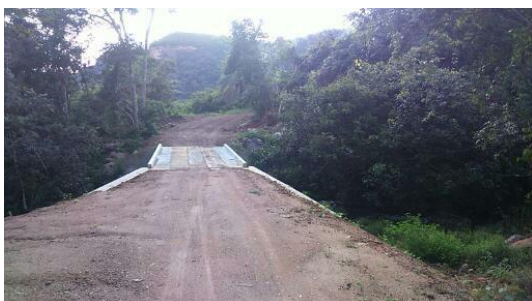
LEGENDA - Ponte nova sobre córrego macacão ,cedida em propriedade de Anísio Moura , a partir de acesso novo vindo da TO-020 para Fazendinha da Serra, Evilson e outros por dentro até a Vicinal de ligação da TO-020 e TO-030
